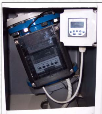
Μετρητής παροχής ασβεστοπολτού γερμανικής προέλευσης
