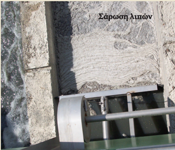
Πλήρως ανοξειδωτη παλινδρομική γέφυρα σε διδυμη δεξαμενή αμμολιποσυλλογής
