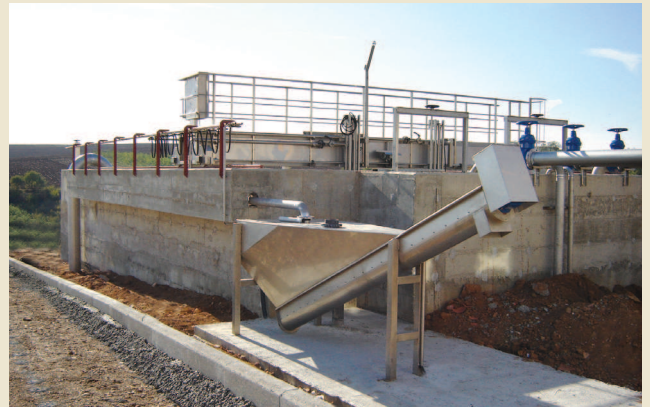
Πλήρως ανοξειδωτη παλινδρομική γέφυρα σε διδυμη δεξαμενή αμμολιποσυλλογής
