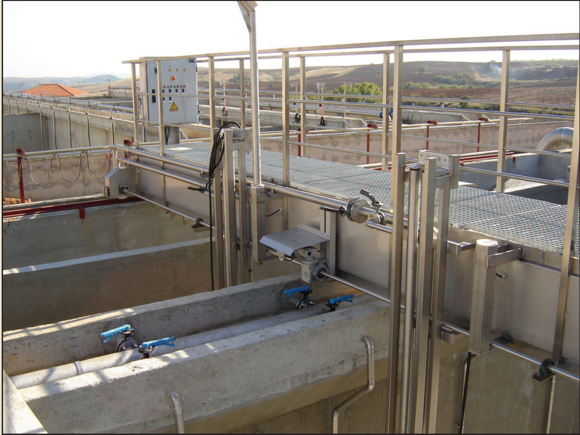
Πλήρως ανοξειδωτη παλινδρομική γέφυρα σε διδυμη δεξαμενή αμμολιποσυλλογής
